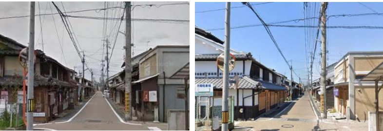
〈2015年〉 — 修理54棟・修景10棟 —> 〈2024年〉
