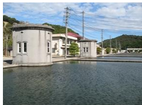
登録有形文化財 忌部浄水場 一号～六号濾過池ほか
