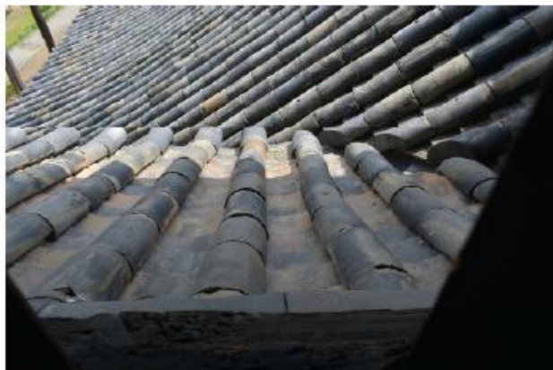
写真1：瓦の乱れ。 1層目、附櫓は古瓦を多く使用している。
