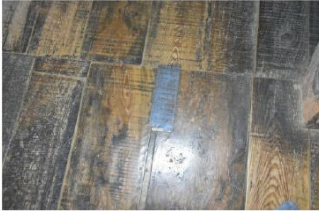
写真9：床板の銅板補修。100カ所近くある。
