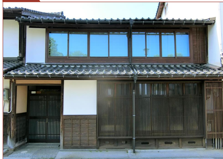
東側（正面） 耐震補強、建具改修等
