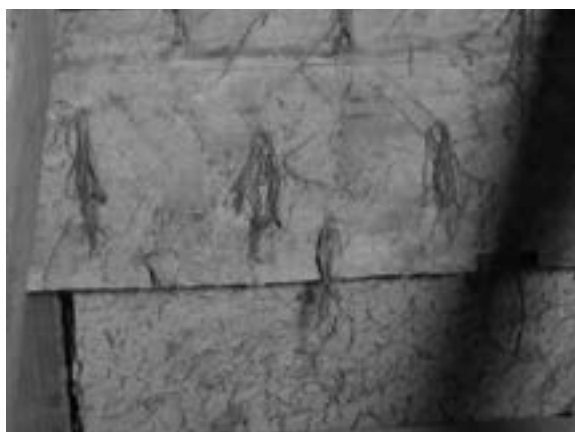
写真3-2-4 ③：梁に残存したひげこと荒壁跡
