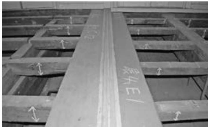
写真3-3-19 写真右側：天端が斫られた展示室4の根太
