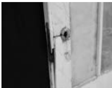
写真3-1-9 建具の腐朽
