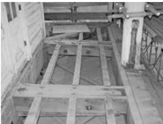
写真3-1-7 挟み梁による過去の補修
