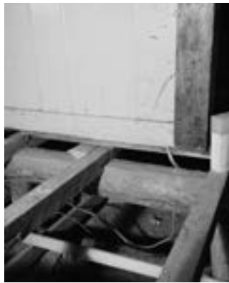
写真3-2-6 ⑤：床板の上に据えられた小階段の柱
