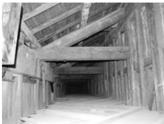
写真3-3-5 ベランダ小屋裏
