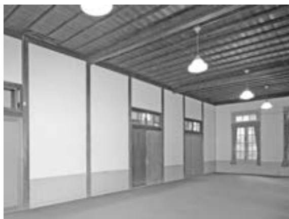
写真3-2-5 ④：天井に残る当初間仕切り壁の廻縁
