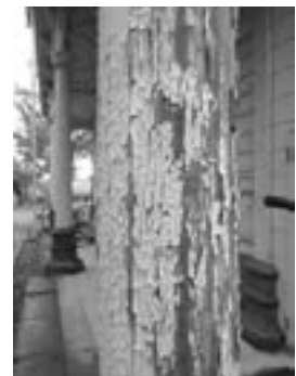
写真3-1-3 列柱の腐朽
