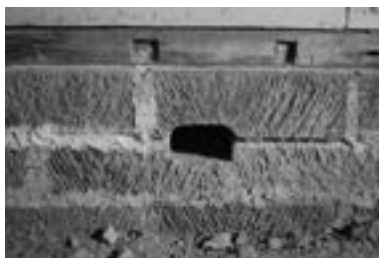
写真3-3-2 建物内部基礎布石（来待石）
