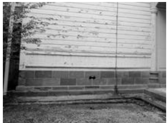
写真3-2-9 ⑧：増築部外周基礎布石の来待石
