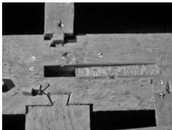
写真3-2-3 ②：床梁に設けた柱柄穴
