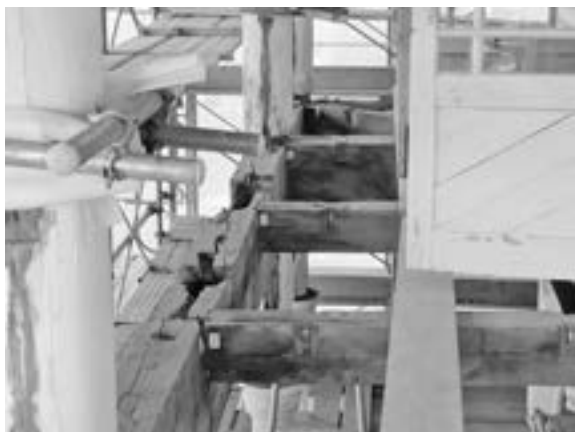
写真3-1-6 腰桁の腐朽
