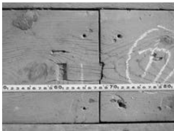
写真3-2-1 ①：床板に設けた柱柄穴の埋木
