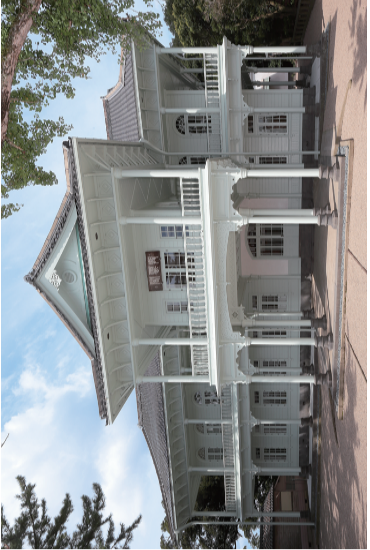
竣工 東・正面全景
