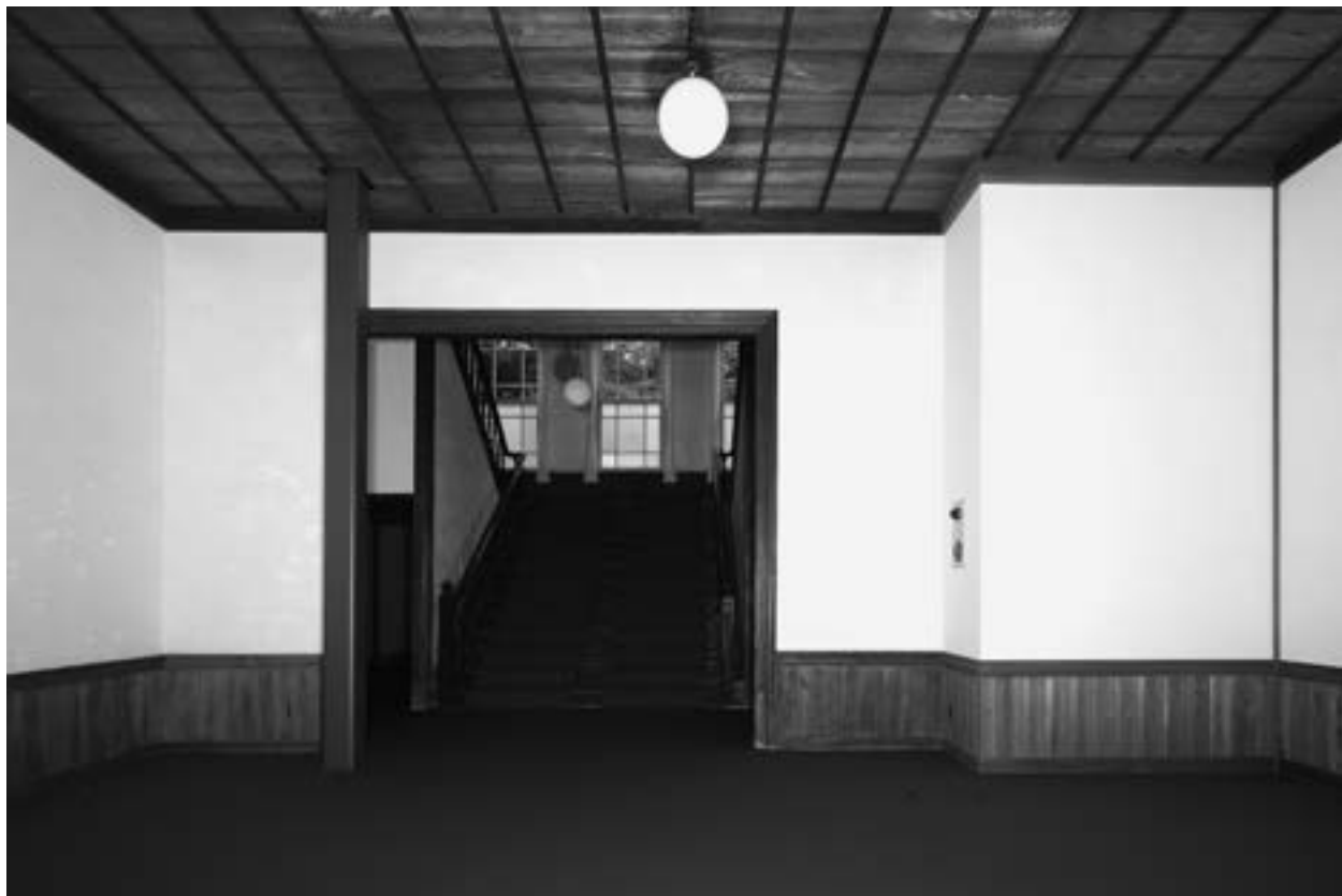
13 ホール・階段室 西面
