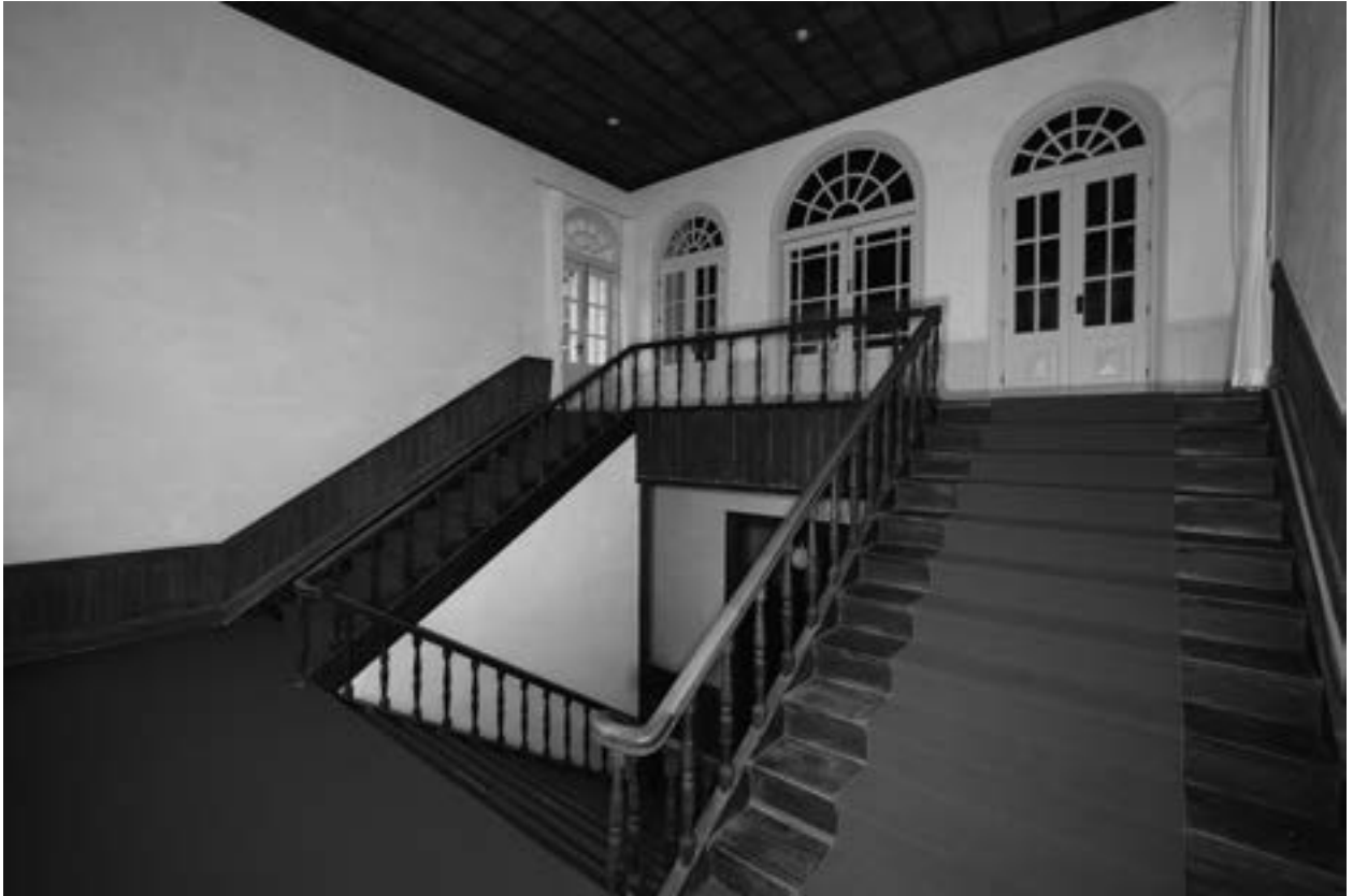
15 階段室 北東面
