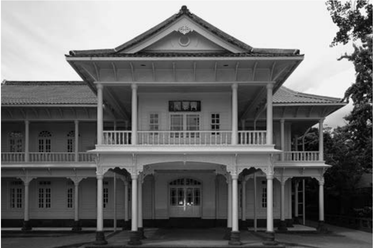
1 東・正面全景
