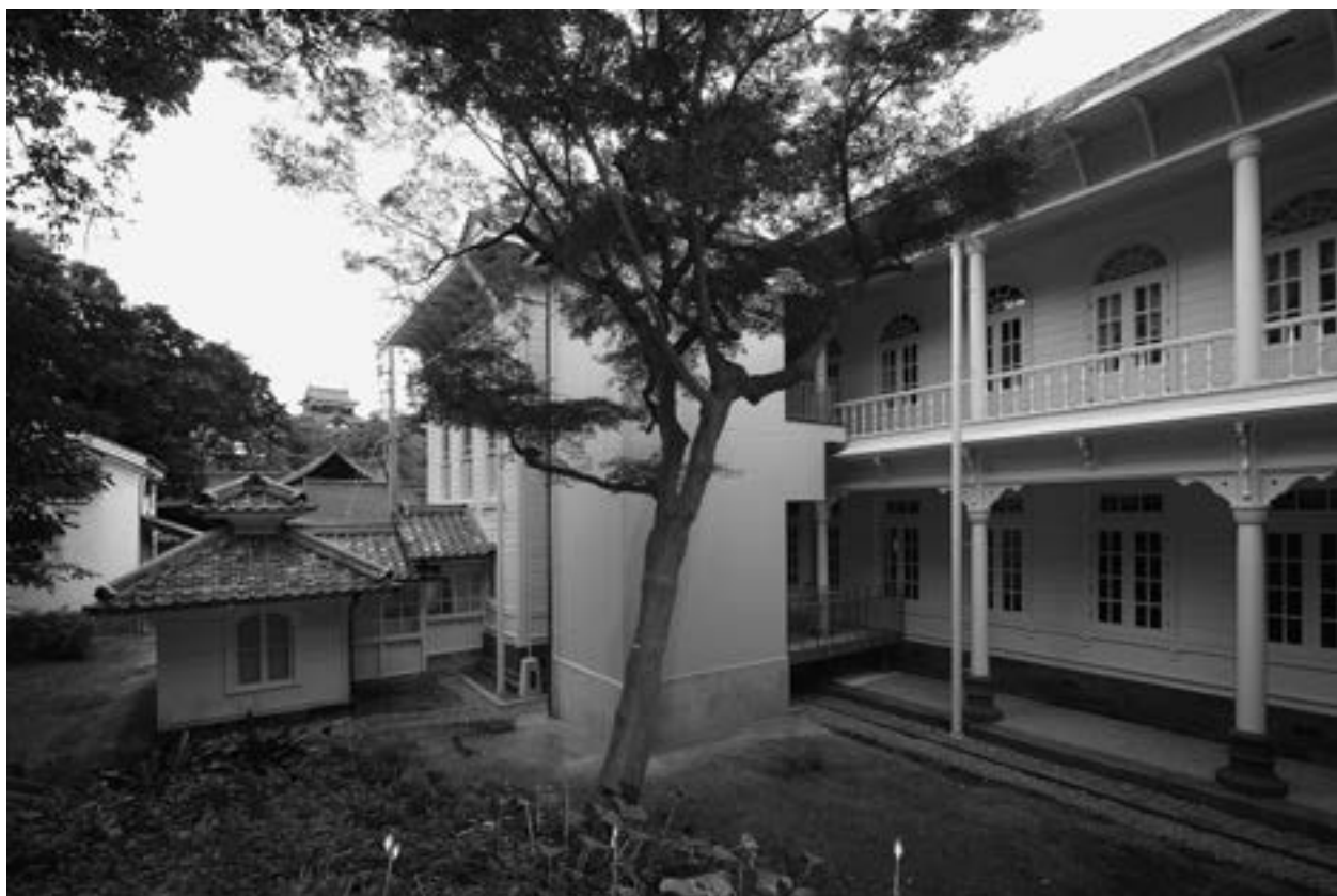
5 南西・背面全景
