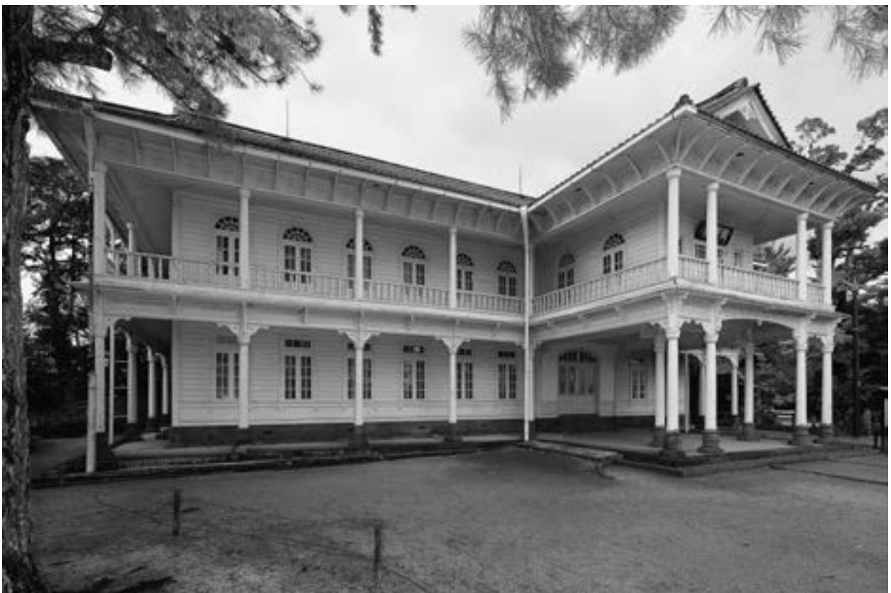
26 東・正面全景
