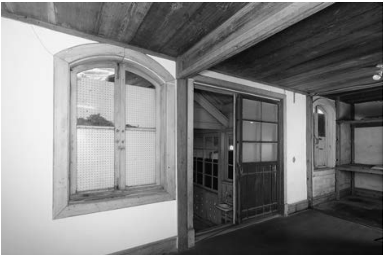
38 階段下通路 西面
