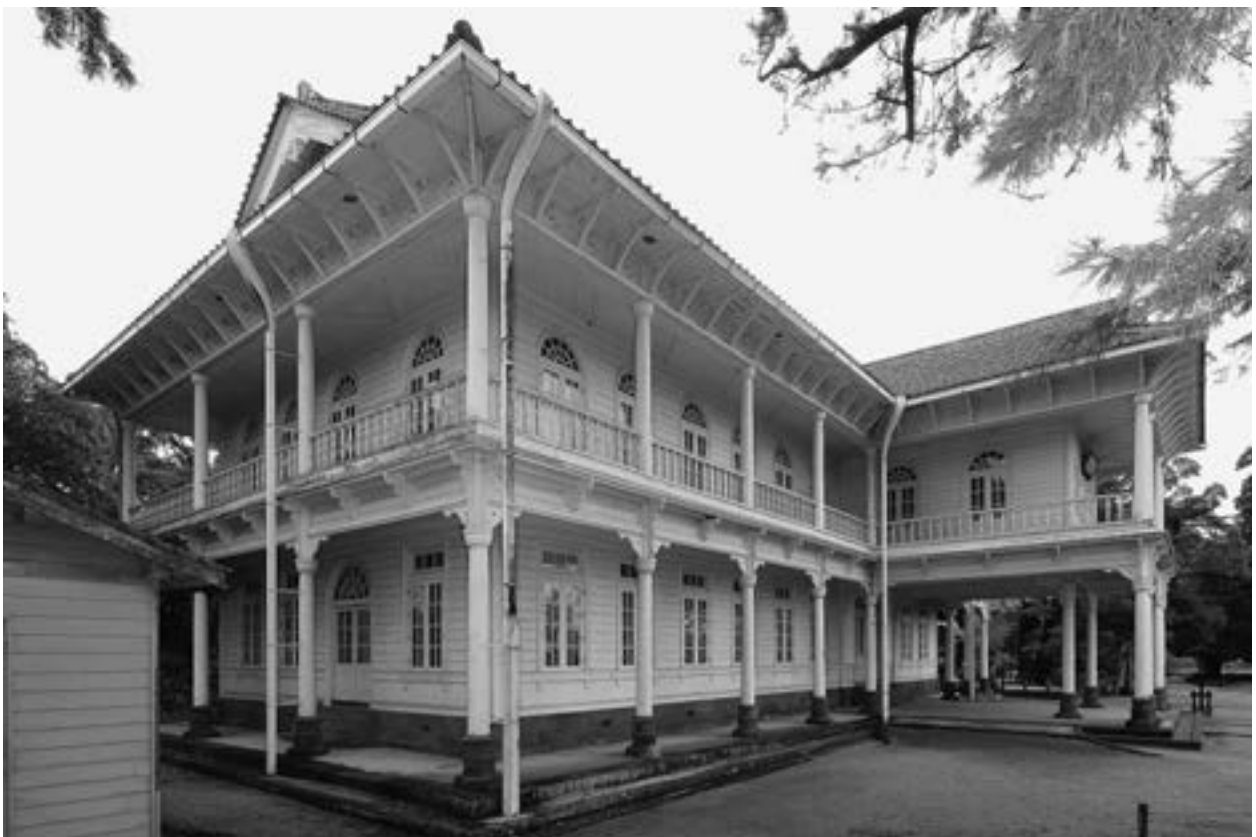
28 南東・正側面全景
