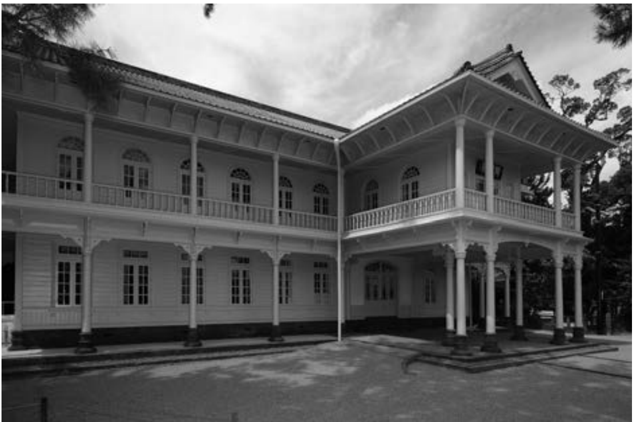
2 東・正面全景
