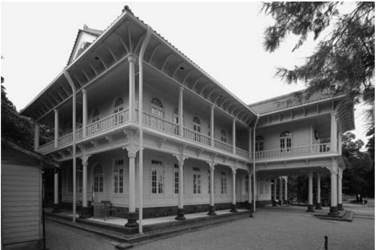
4 南東・正側面全景
