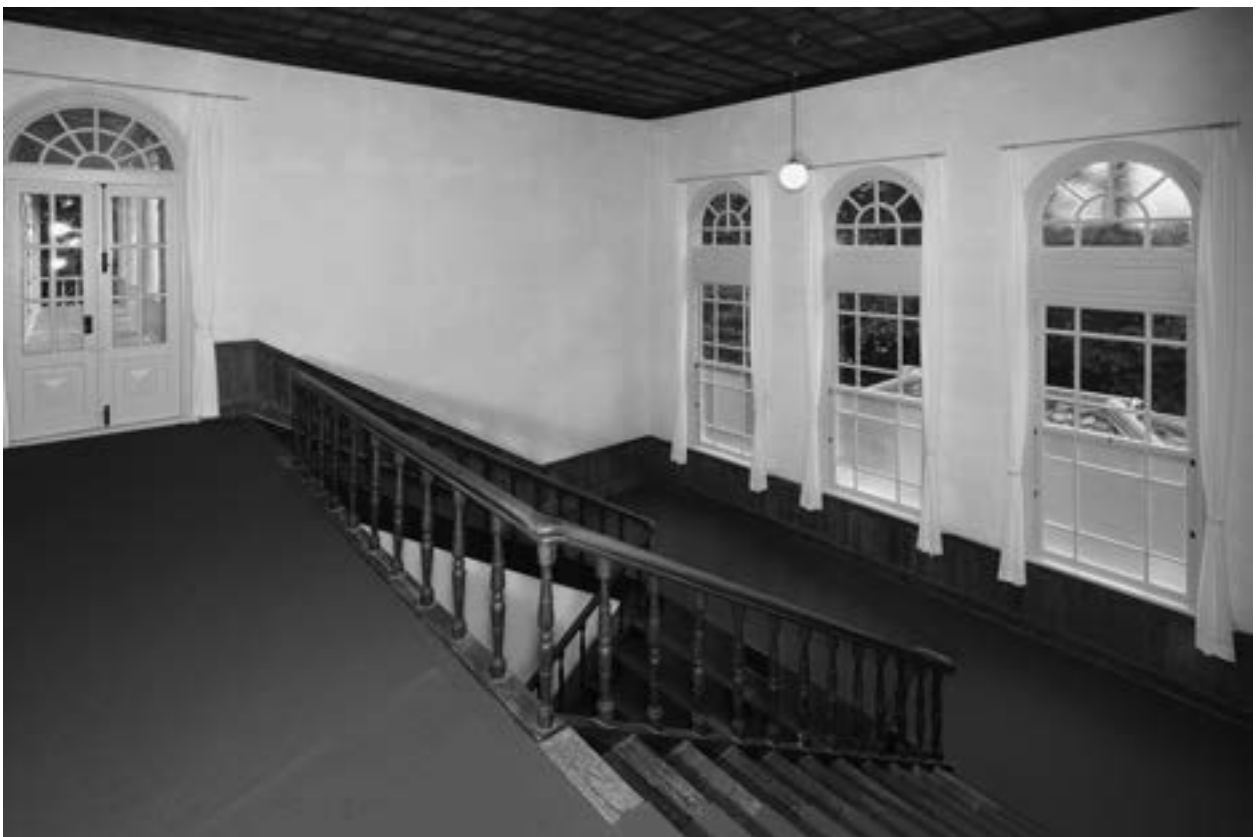
16 階段室 南西面
