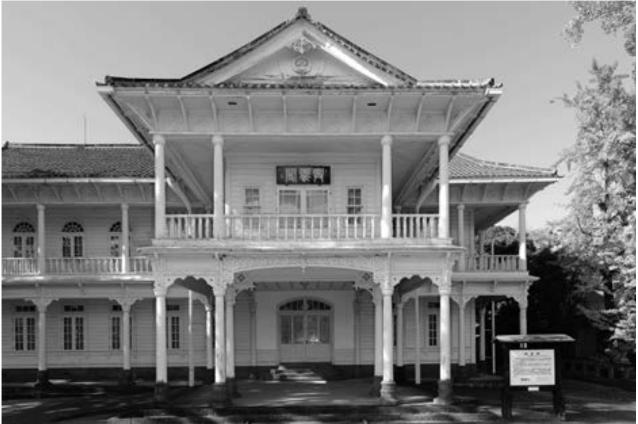
25 東・正面全景
