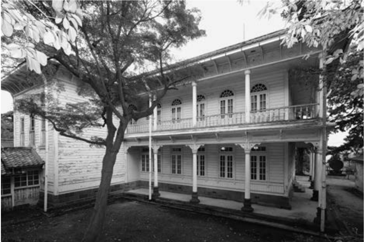
29 南西・背面全景
