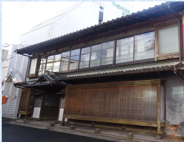
北棟正面：外観
