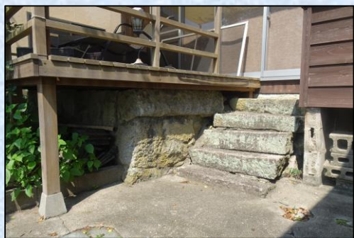
ようへき 石の擁壁と階段
