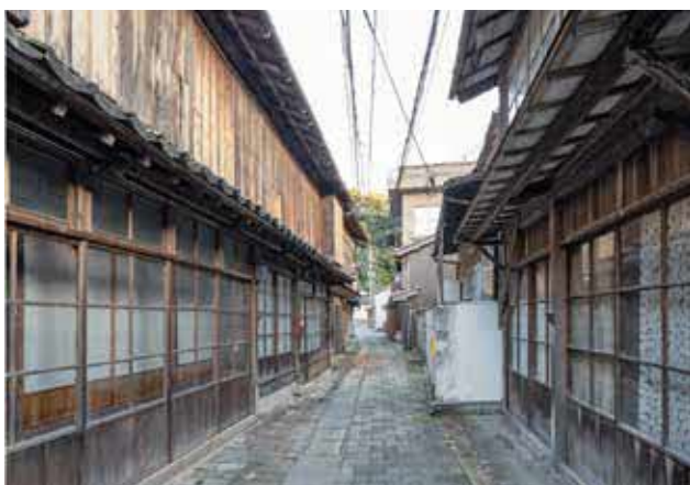
切妻造・平入町家が並ぶ本通り
