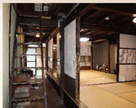
(※2) 1階通り土間と居室部
