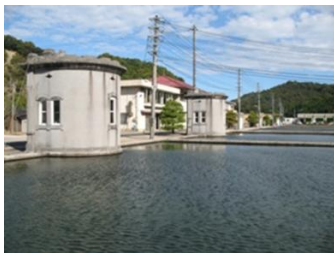
登録有形文化財 忌部浄水場 一号～六号濾過池
