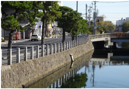
外堀（ きょうばし 京橋川）と東京橋交差点
