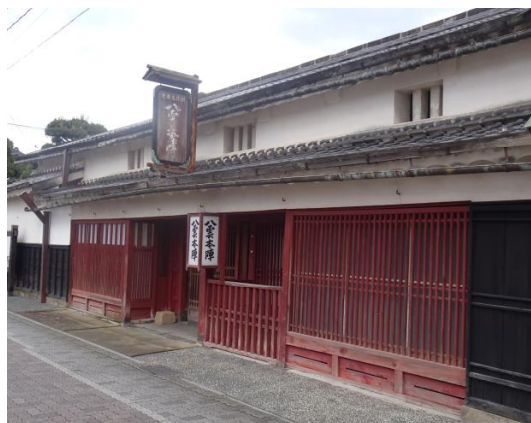
木幡家住宅主屋（重要文化財）
