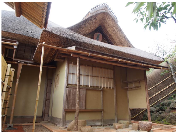
菅田庵（重要文化財建造物）
