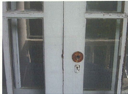
(写真 8-2) 建具握手の欠損
