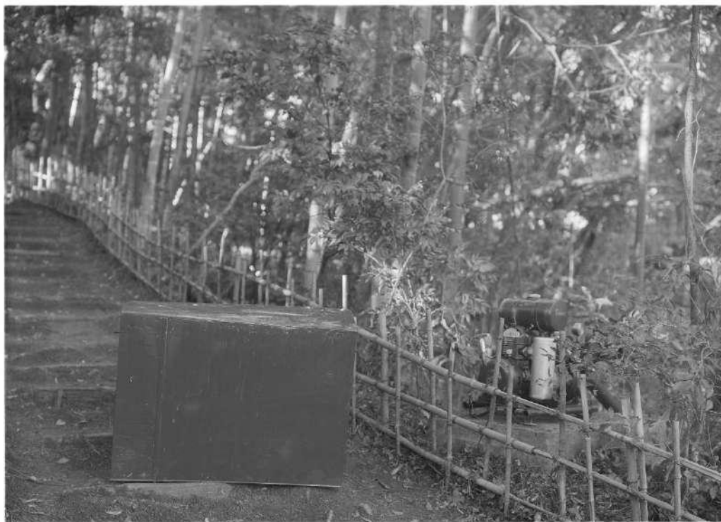
写真資料 19 御風呂屋に至る池辺の道に設置された消防用エンジンポンプ とカバー 昭和 29(1954)年頃 ガラス乾板写真 松江市蔵
