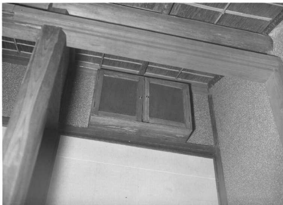
写真資料 21 菅田庵の水屋の縁に設置された分布型感知器の収納ボックス 昭和 29(1954)年頃 ガラス乾板写真 松江市蔵
