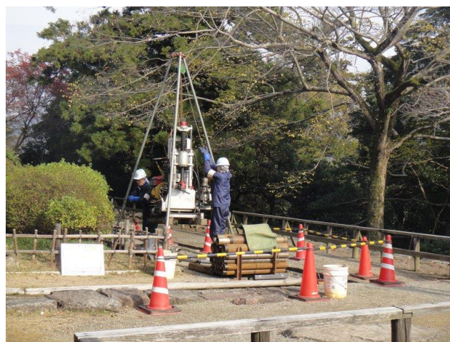
地盤調査（ボーリング）
