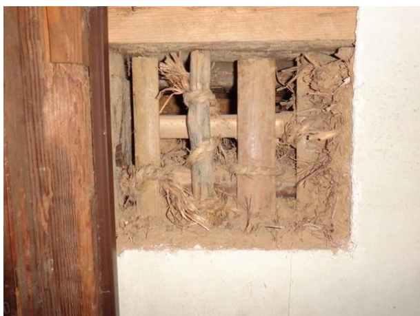
壁内部確認調査
