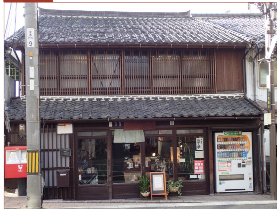
東側（正面） 屋根修繕、2階開口部修繕 格子取付
