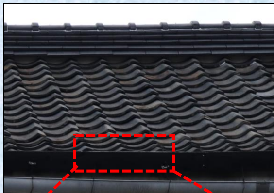
西面外観【屋根瓦】
