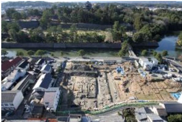
松江歴史館部分の発掘調査風景
