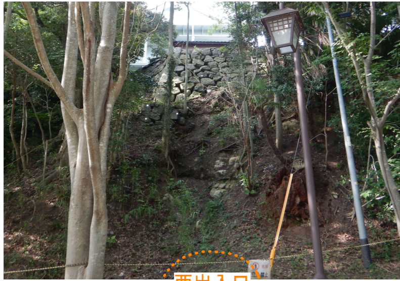
月見櫓下石垣※解体前（南から）
