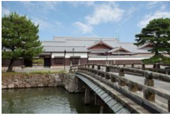
写真2-8 北惣門橋側から見た松江歴史館正面
