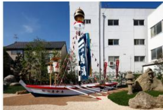
写真2-11 松江ホーランエンヤ伝承館の中庭
