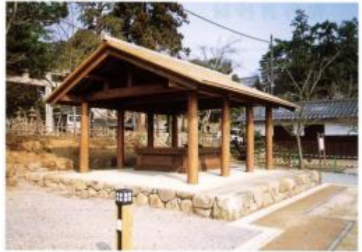
写真3-27 二之丸井戸屋形整備状況 (平成12年度 [2000])
