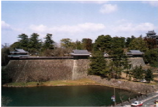
写真 3-32 二之丸櫓・塀整備状況 (南東より)
