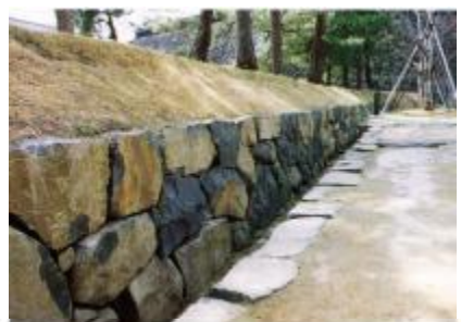
写真 3-38 馬溜腰石垣整備状況 （平成 11 年度〔1999〕）
