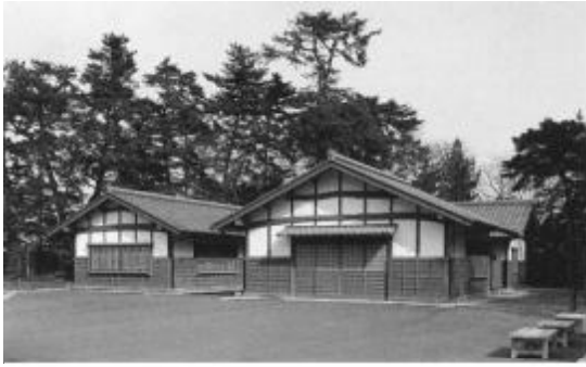
写真3-40 休憩施設整備状況 (平成6年度 [1994])
