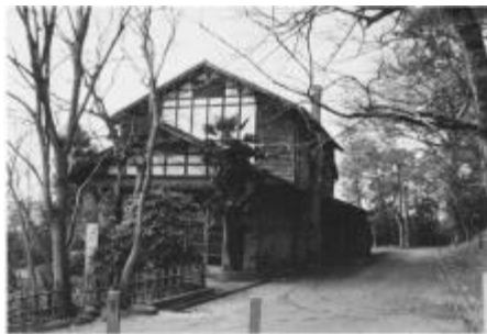
写真 3-42 県施設の職員会館（椿谷会館） （撤去前）
