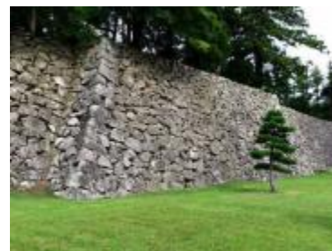
写真4-7 中曲輪東側石垣
