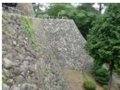
写真4-8 本丸祈禱櫓下石垣
