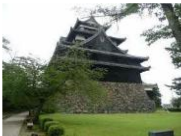
写真4-2 本丸天守台石垣
