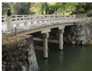
写真4-17 千鳥橋・橋台石垣
