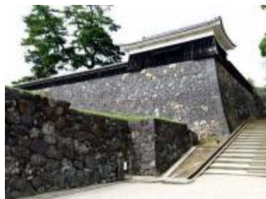
写真4-11 二之丸高石垣北東部
