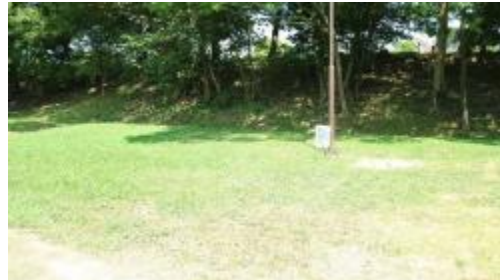
写真4-24 二之丸下ノ段の土羽
