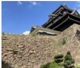
写真4-3 本丸東側石垣 (写真左側)
