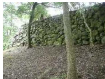
写真4-4 本丸北側石垣
