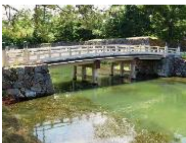
写真4-16 北惣門橋・橋台石垣
