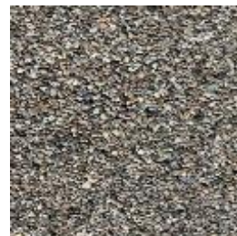
写真6-19 アスファルト系舗装（脱色アスファルト舗装）
