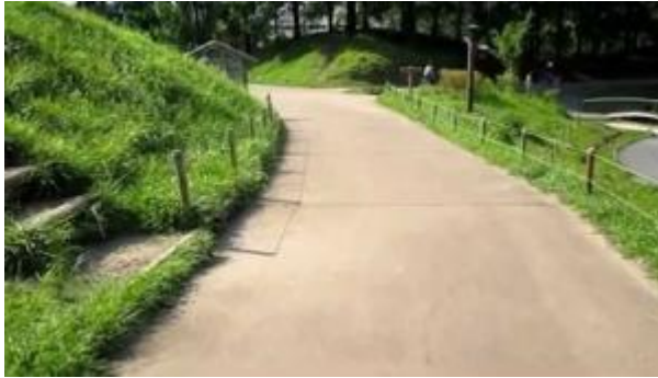
写真6-13 土固化系舗装（カラーサンド舗装）
