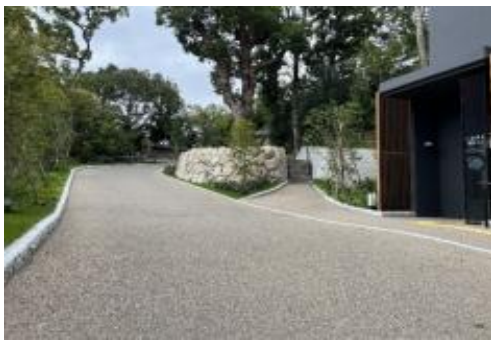
写真6-15 アスファルト系舗装（脱色アスファルト舗装） ※高宮南緑地（旧高宮貝島家住宅高宮庭園茶寮）
