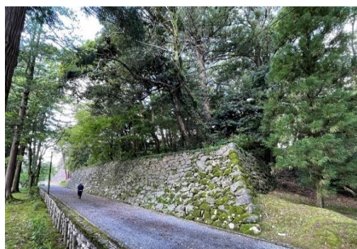
↑伐採前（北東から）
