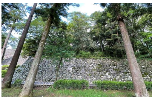
↑伐採前（東から）
