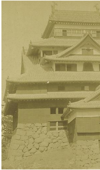
【写真 A】の正面左側
