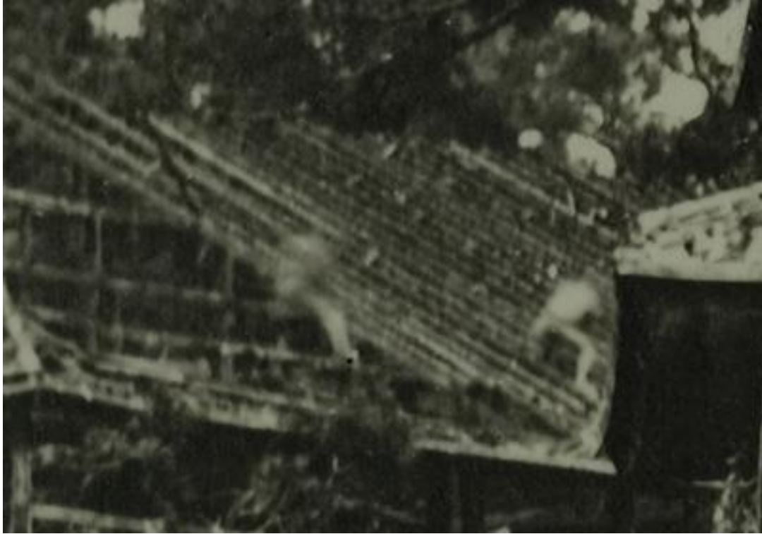
【写真3の部分拡大3】月見櫓の屋根には解体作業中の人物が複数写る
