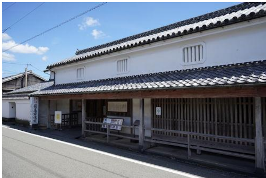
【写真 3-1】菊屋家住宅（山口県萩市呉服町）正面外観
