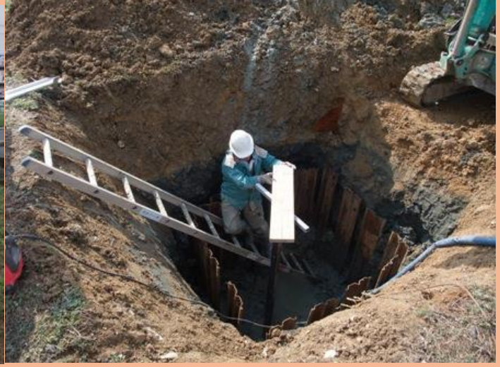
ジオスライサー打ち込み中の様子
