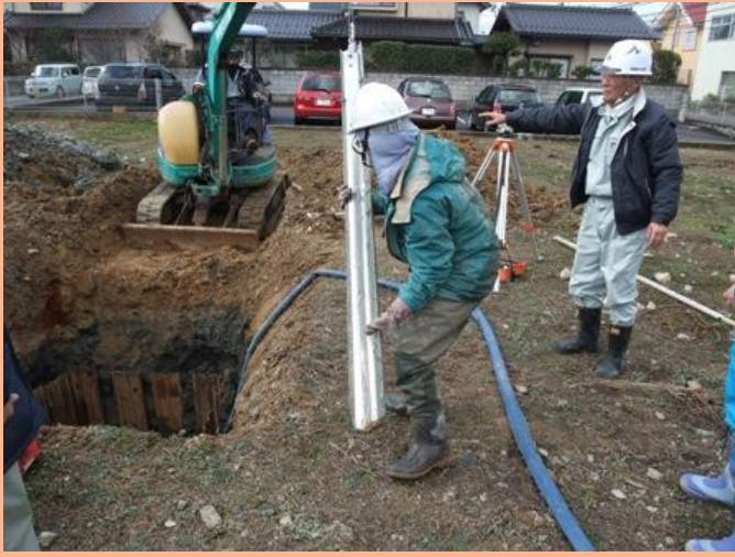
ジオスライサー抜き取り風景
