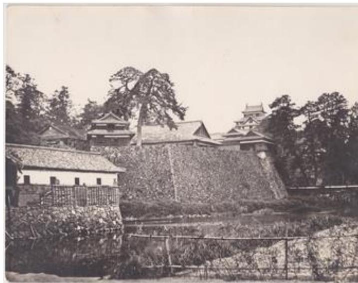
↓【写真Dの部分拡大】二之丸内の御書院、南櫓：御書院屋根の解体作業、南櫓二階窓格子の取り外し途中の様子が確認出来る。
