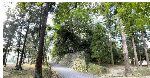
北東方向から(現状)
