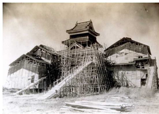
図7 昭和の解体修理工事
