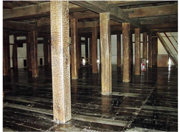
図9 大天守1階内部
