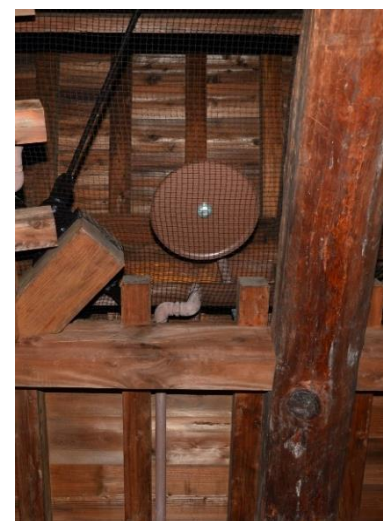
現状の設備 閉鎖型湿式スプリンクラー
