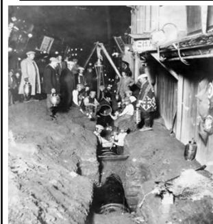
末次本町の夜間工事(大正6年4月)
