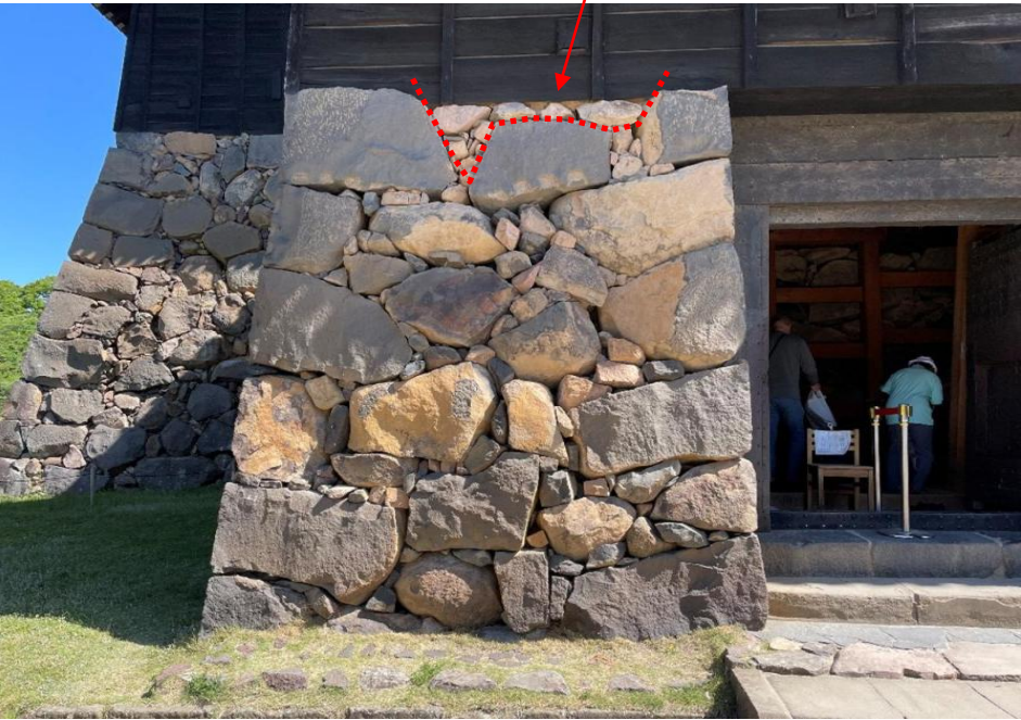
修理推定範囲（間詰め石の交換程度）
