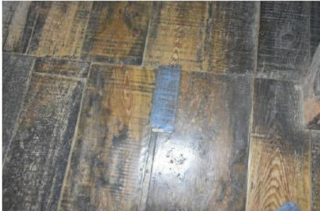
写真9：床板の銅板補修。100カ所近くある。
