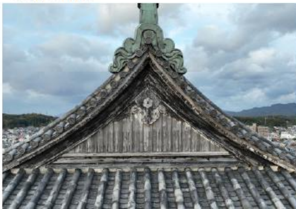
写真7：5層妻面 白塗装が剥げている。六葉が欠失し、懸魚は欠けている。
