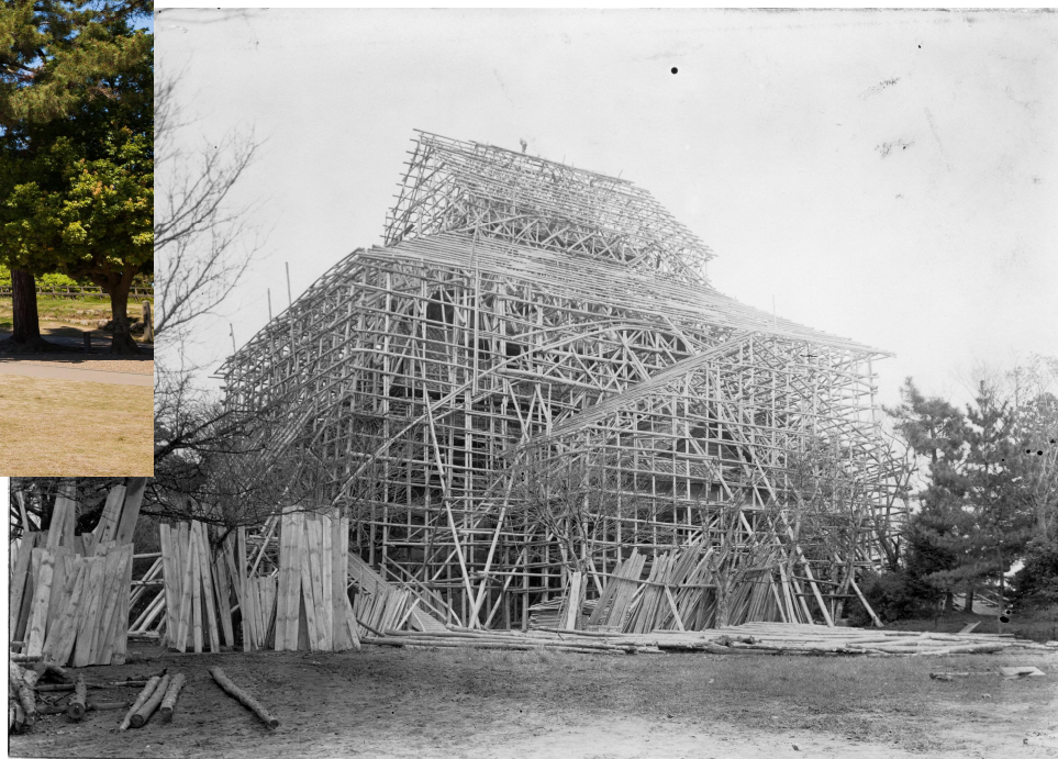
松江城天守「昭和の大修理」(素屋根設置工事の様子)
