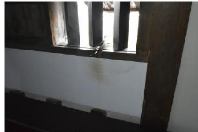
写真12：鎖の痕が養生ベニヤに残る。
