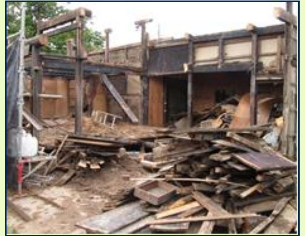
危険家屋の取壊し
