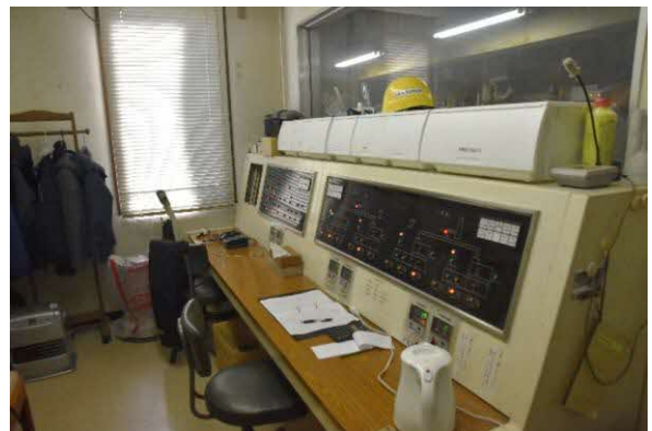
写真 74 ディスク型制御盤
