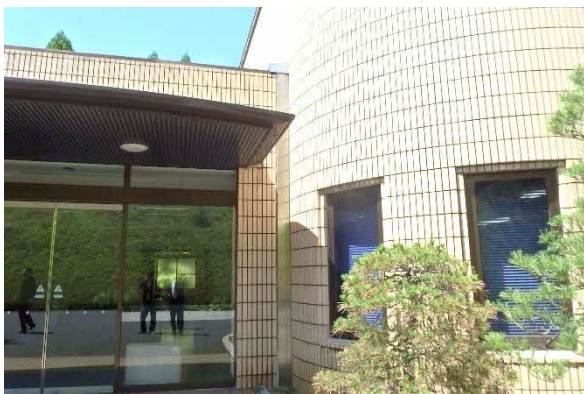
写真 31 エクスパンション外部
