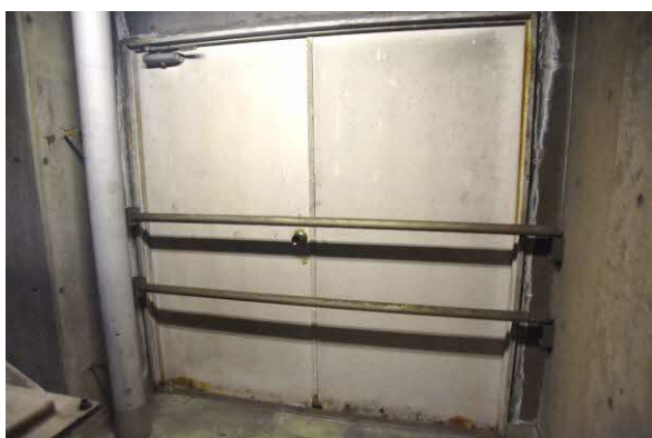
写真 81 2 階部分マシンハッチ室内側
