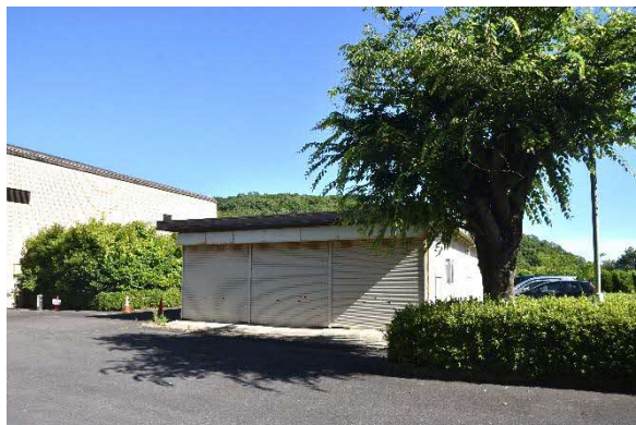
写真 78 増築された倉庫
