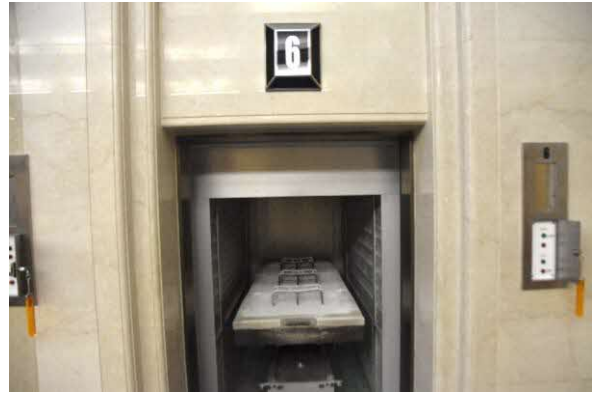
写真 70 6号炉前室と耐火台車
