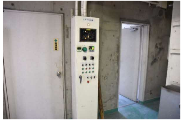
写真 62 6号炉制御盤
