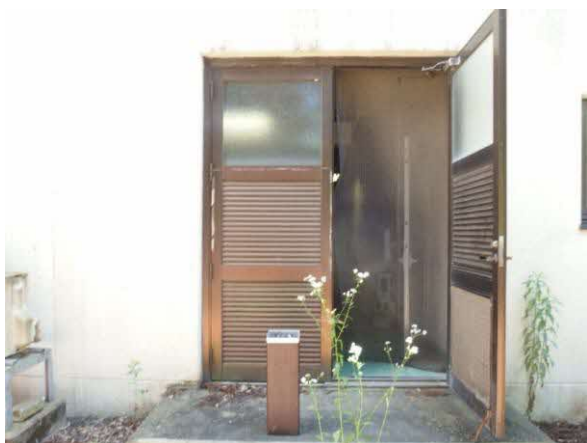
写真 79 1 階部分マシンハッチ
