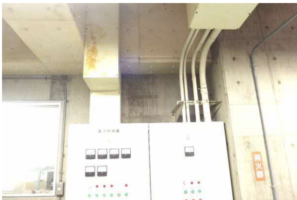
写真 75 動力制御盤
