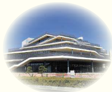
松江市役所新庁舎
