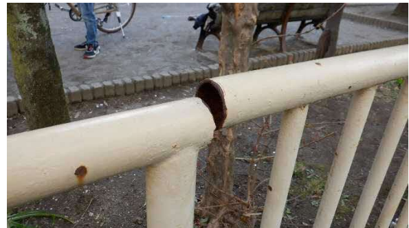
パイプ柵破断状況
