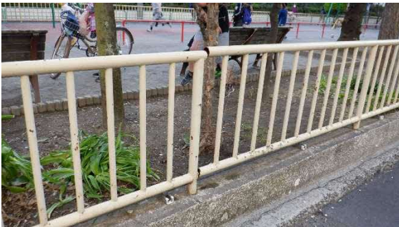
パイプ柵破断状況
