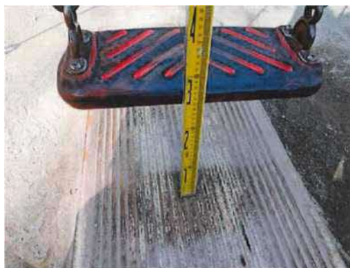
令和元年度点検状況 クリアランス 250mm
