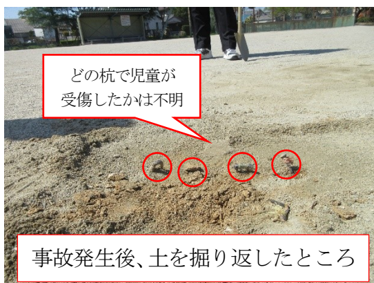
埋設された杭等
