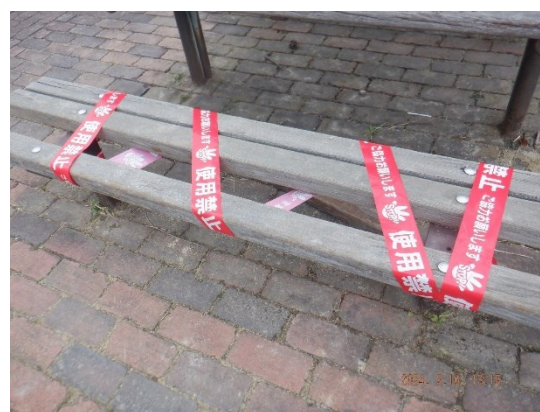
応急措置状況
