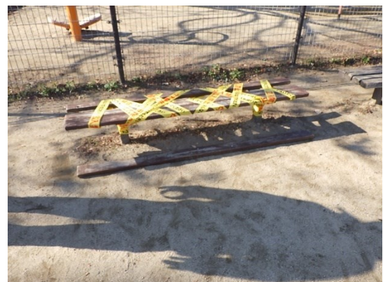
応急措置状況
