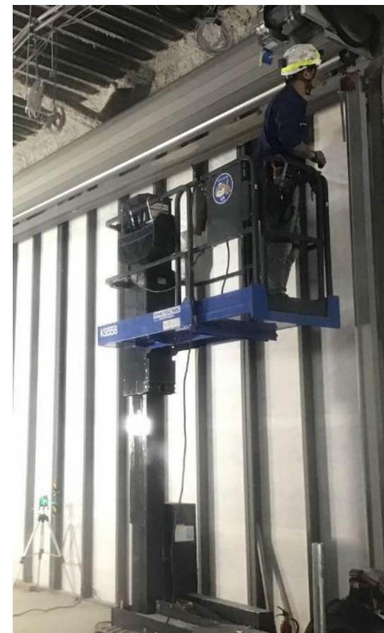
内装工事（シャッター取付）の様子
