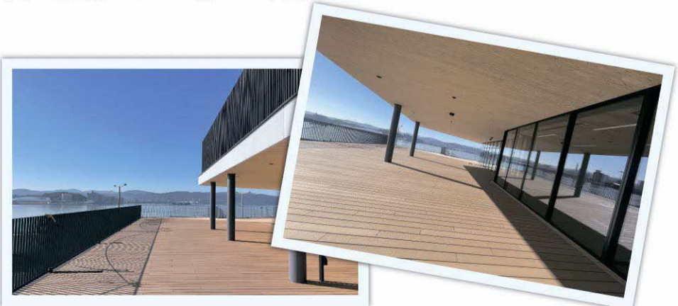
2階テラス東側
