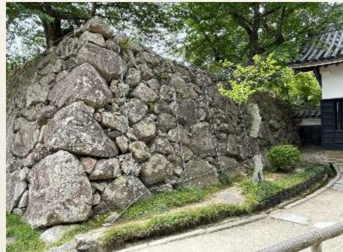
松江城内での施工事例(一之門前)
