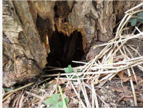
根が腐食し 倒壊の恐れ
