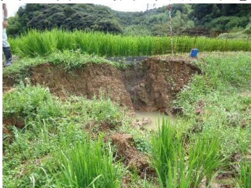
水田法面崩落（鹿島町北講武）
