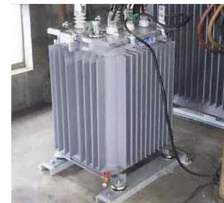
工場設備の変圧器更新
